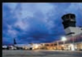
AEROPUERTO INTERNACIONAL DE SALTA
